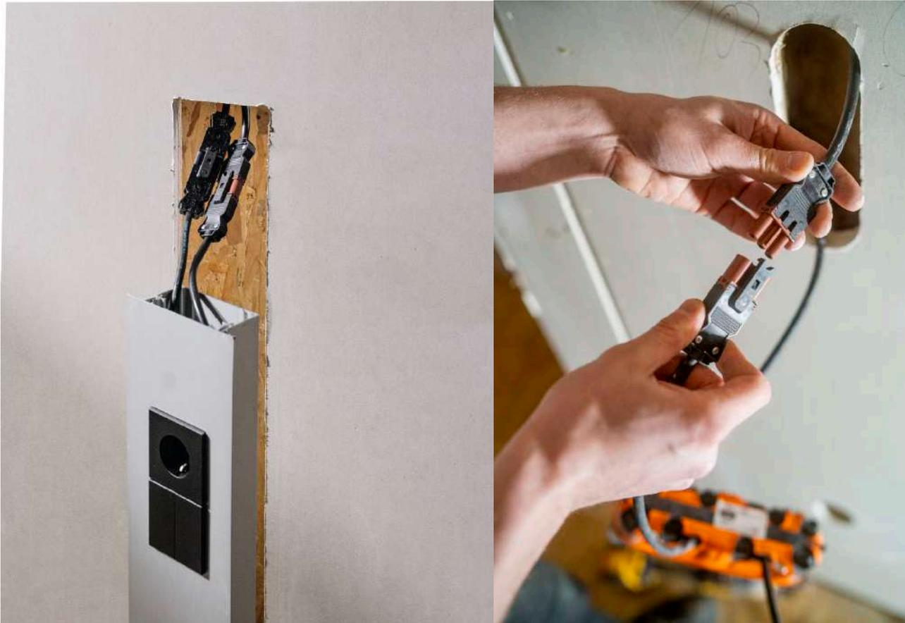
Se aprovechan los huecos de la construcción para optimizar el trazado y ocultamiento de los elementos de la instalación eléctrica.
