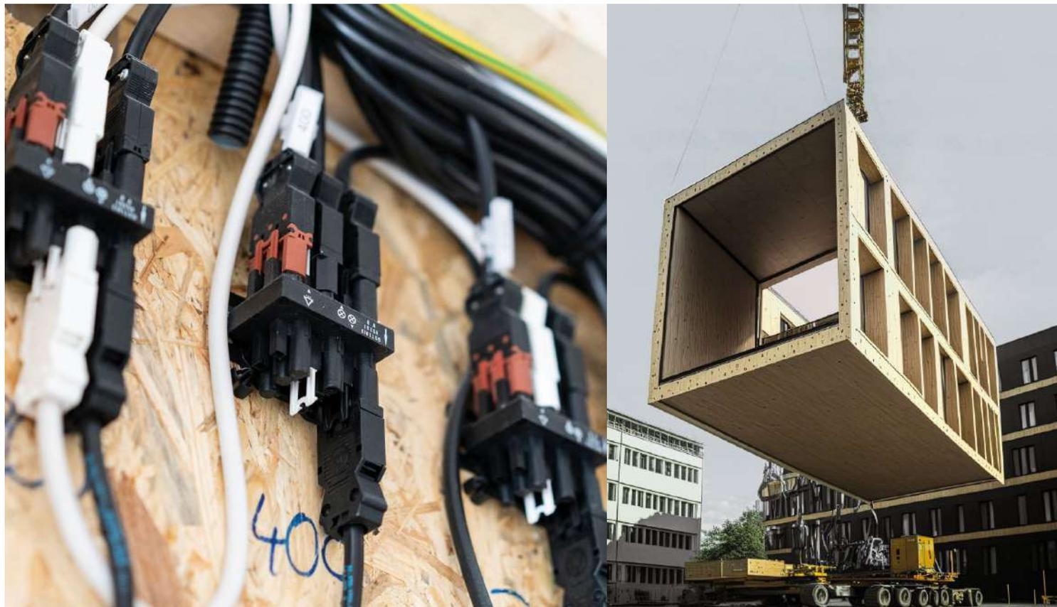
Se aprovechan los huecos de la construcción para optimizar el trazado y ocultamiento de los elementos de la instalación eléctrica.
