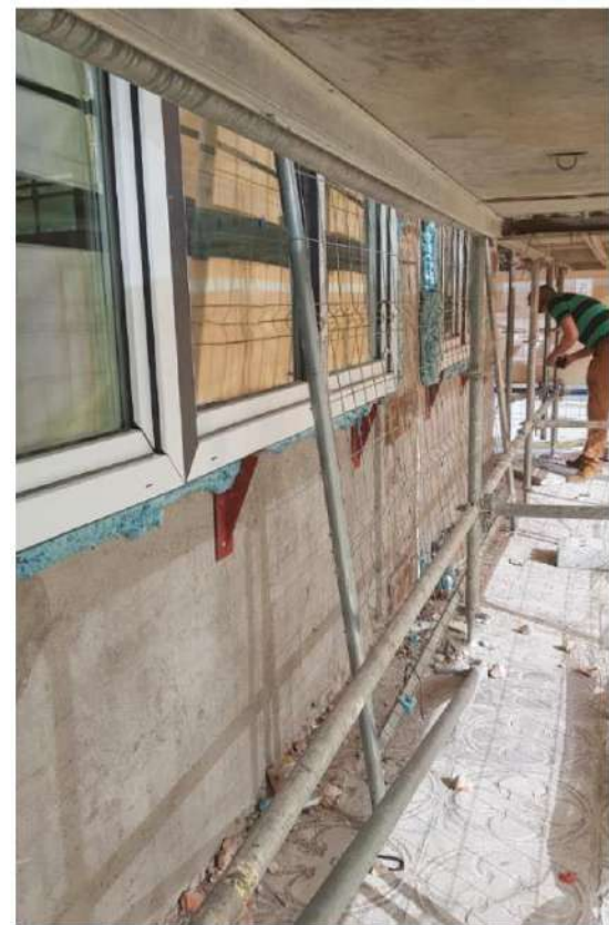
13. Detalle de carpintería exterior.
