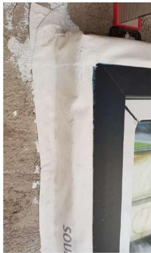
14. Sellado con Flexifoam y Outside tape .
