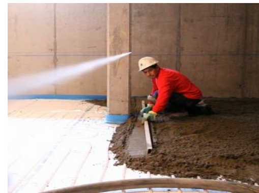
Losa de mortero
