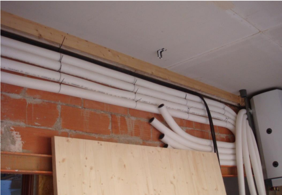
Sistema de tubos distribución : Zehnder ComfoTube
